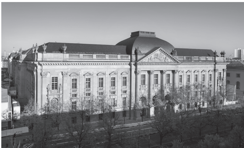
Biblioteka Państwowa w Berlinie. Budynek przy ulicy Unter den Linden 8
