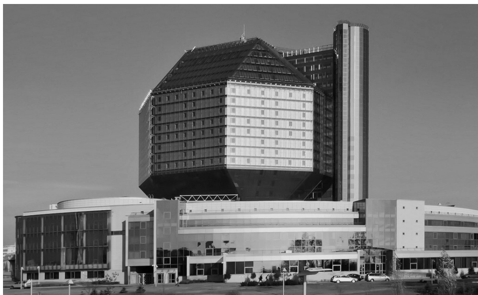
Fot. 5. Wieża przystępna-falszywa: M. VINOGRADOV, V. KRAMARENKO Nacionalnaja Biblioteka Bielarusi . 2006. Fot. Victor Shaposhnikov
